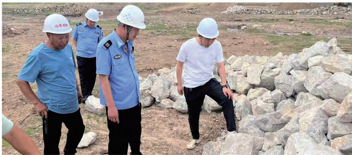
潮白河赤城段防洪治理工程现场检查
