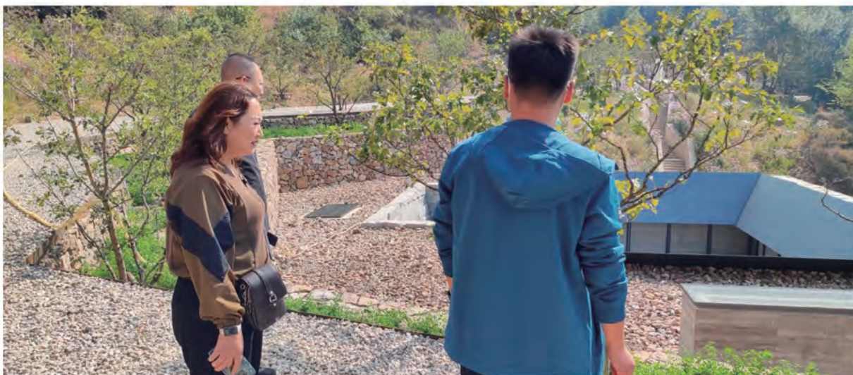
承德阿那亚建设项目现场检查
