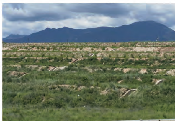
丰宁鑫源钼矿尾矿库防护措施
