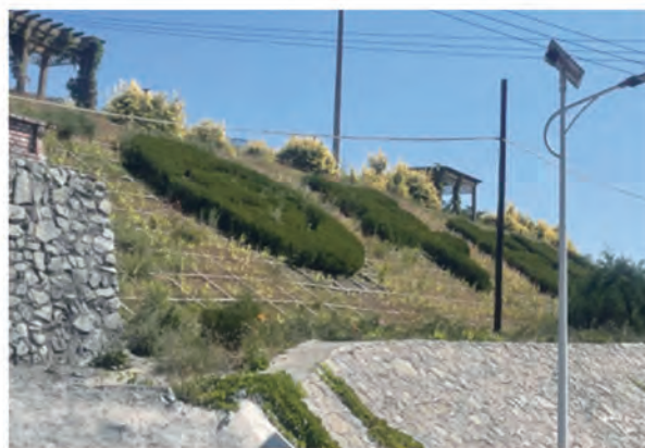
丰宁建宇杨营铁矿护坡工程
