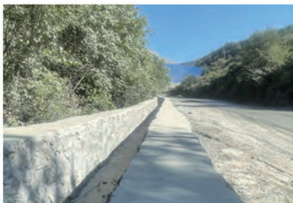
丰宁石人沟金利来金矿拦挡工程
